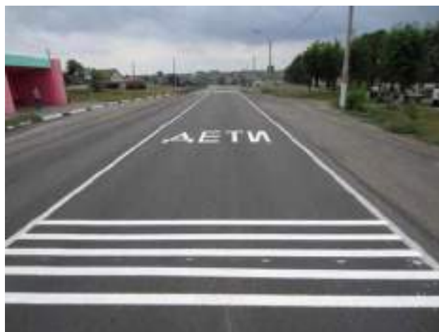
Рисунок 4.15.2 – Пример использования шумовых полос
