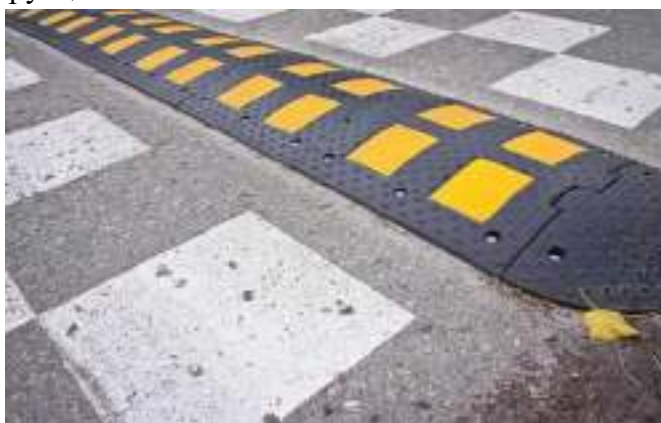
Рисунок 4.15.3 – Пример исполнения искусственной неровности сборно-разборной конструкции
